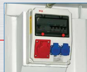
skrzynka rozdzielcza ze zintegrowanymi gniazdkami
