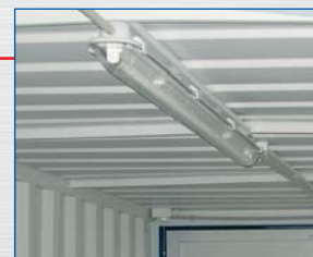
światłówki z włącznikiem do pomieszczeń wilgotnych
