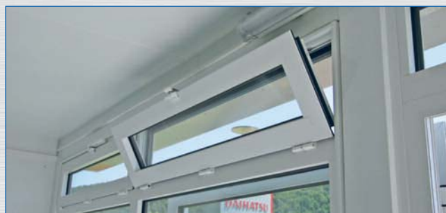
Świetliki – opcjonalne uruchamianie siłownika podnoszącego
